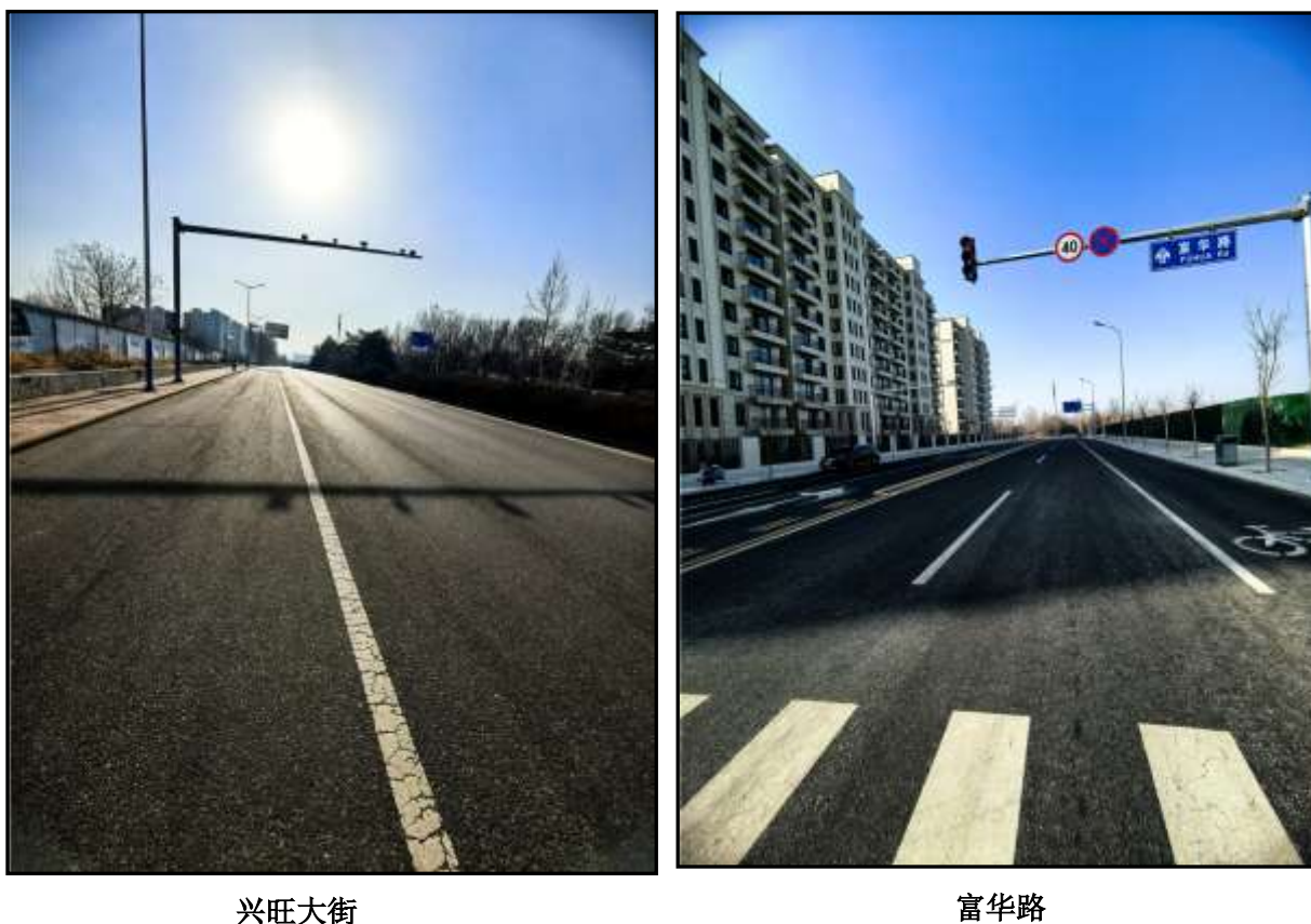
图 3-1 (1) 项目周边现状道路照片
